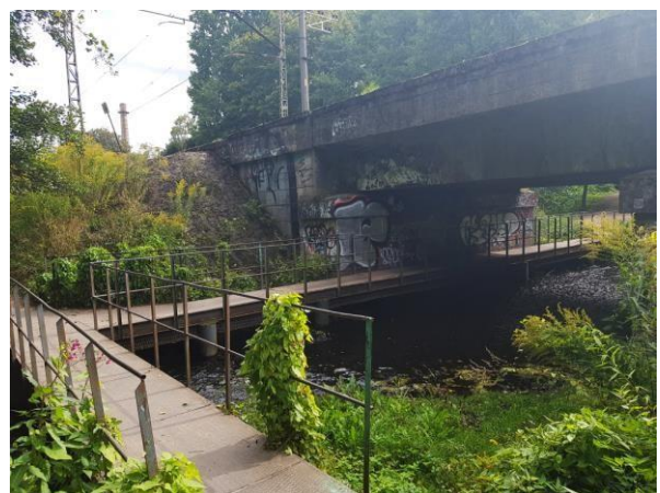
Point A , vue du NW
